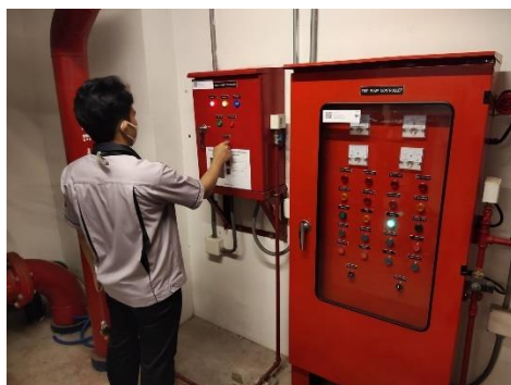
เจ้าหน้าที่ตรวจสอบ Fire Pump
